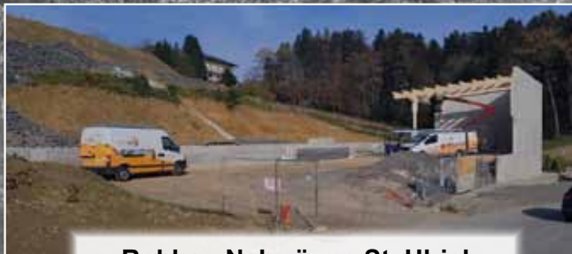
Rohbau Nahwärme St. Ulrich
